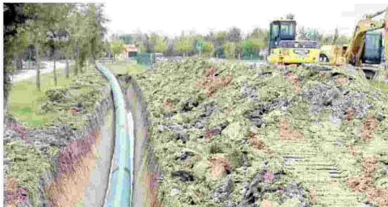
INVESTIMENTI Sono 7,5 i milioni che Acquevenete investirà in Polesine per nuove condotte
