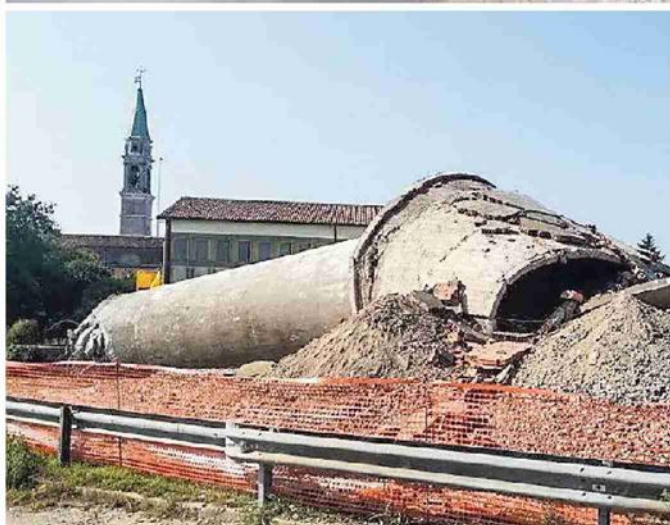
Sopra l'esplosione e sotto la torre dell'acquedotto distrutta a terra
