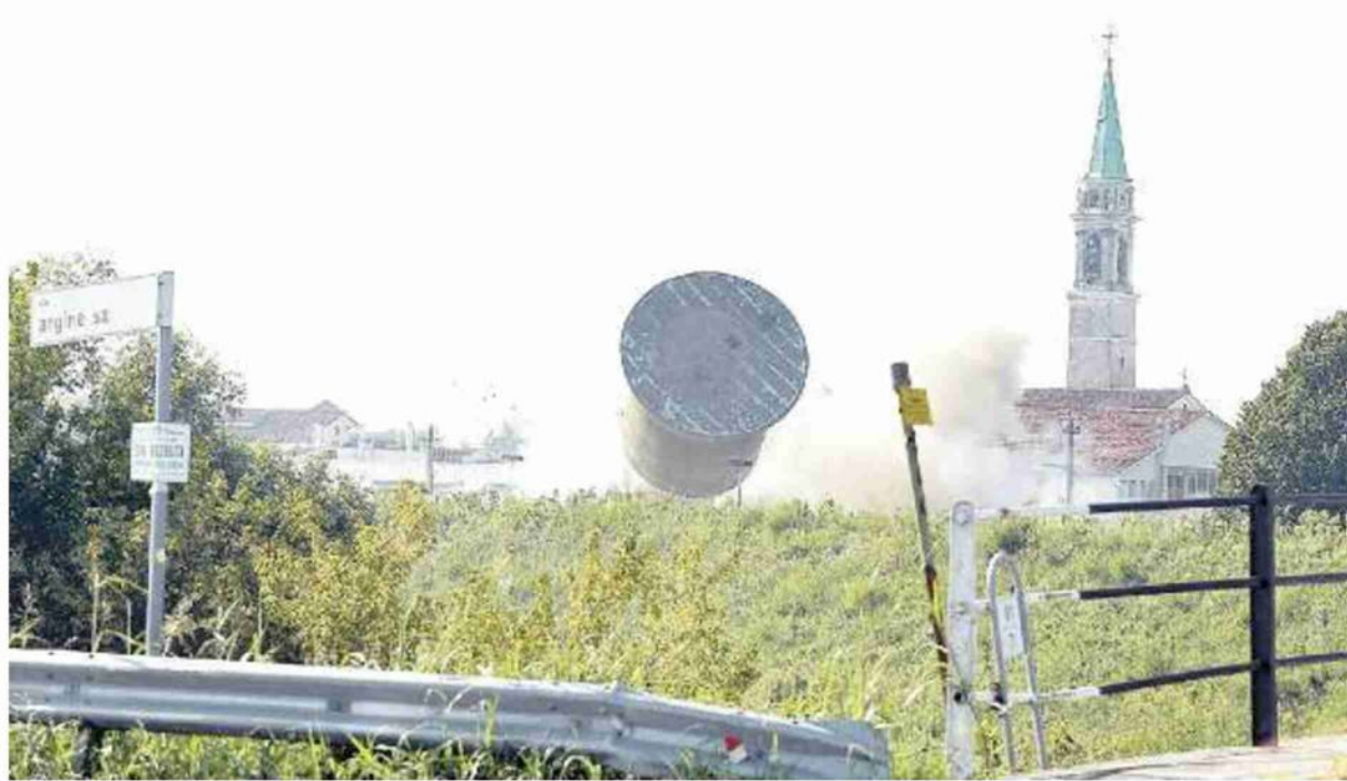
LA CADUTA Una sequenza segnalata da tre sirene ha preceduto il crollo del vecchio serbatoio dell'acqua alto trenta metri
