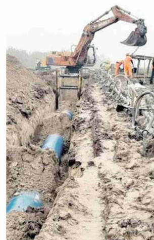
CANTIERE Lavori per il serbatoio di Montagnana: sarà il baricentro della nuova condotta che fornirà acqua senza Pfas
