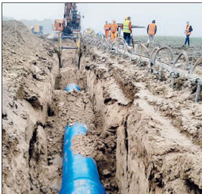
Il sopralluogo nell'area del cantiere anti-Pfas
