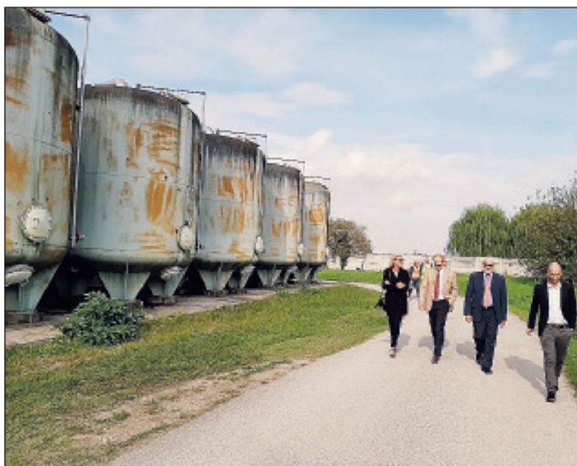
Sopralluogo alla centrale idrica di Boara qualche tempo fa
