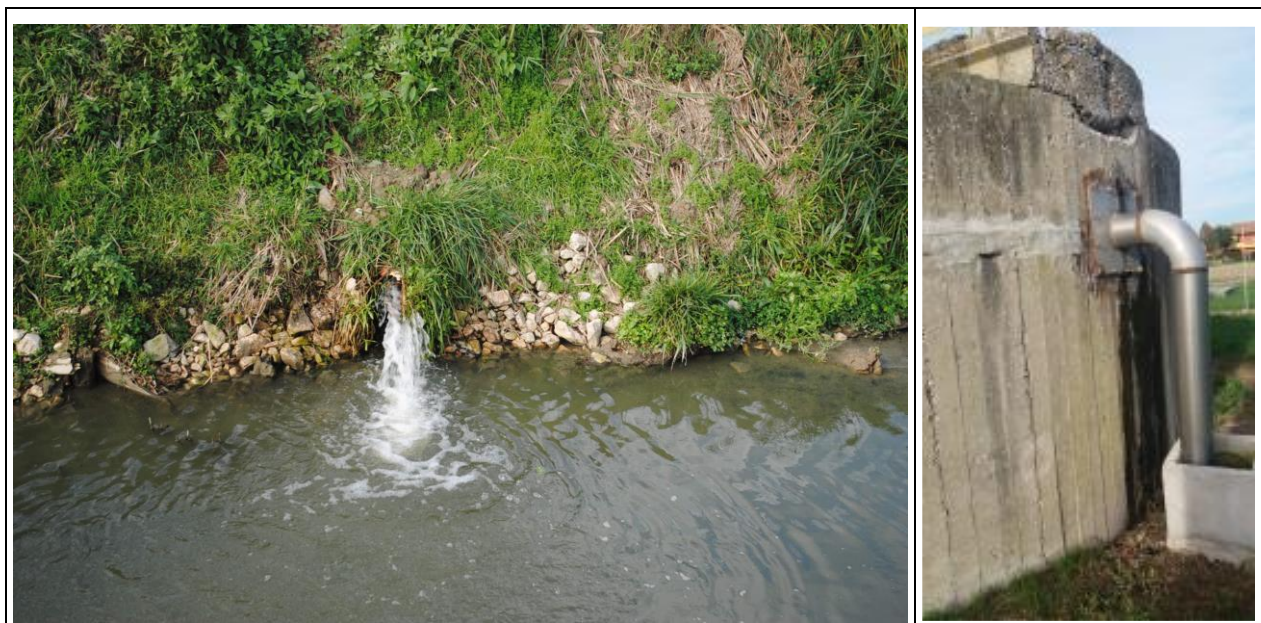
Figura 11 – Condotta di scarico al ricettore finale dell'effluente depurato
