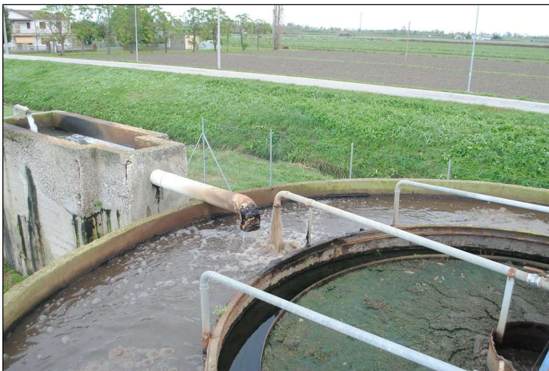
Figura 10 – Vasca circolare compatta di ossidazione e decantazione
